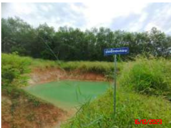
รูปที่ 16 บ่อดักตะกอน บ่อปรับสภาพน้ำ และบ่อบำบัดน้ำ
